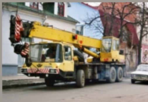
Der einzige Kran in Munkács, der das CT heben konnte, wurde vom Oberbürgermeister kostenfrei bereitgestellt
