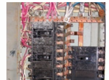
Typische Elektroversorgung im Städtischen Krankenhaus
