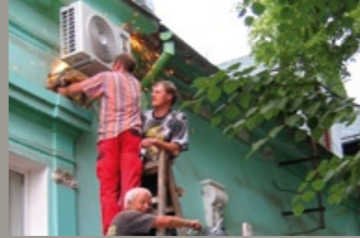
Installation der Klimaanlage für das CT
