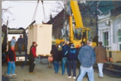
Entladen des CT-Ringes mit 1500 kg Gewicht
