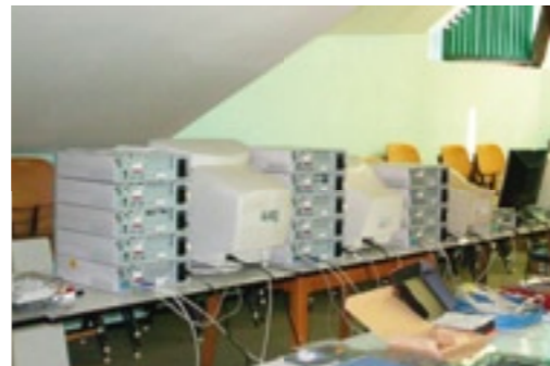
Das Netzwerk wird konfiguriert und getestet: erst in einem großen Raum um dann später in den einzelnen Arbeitszimmern installiert zu werden
