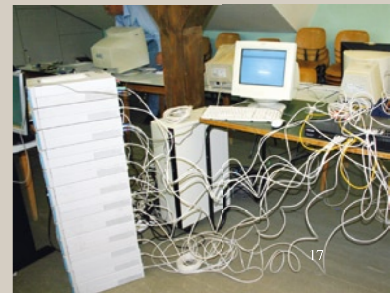
Eine komplexe Arbeit: aus diesem Kabelsalat wird später ein funktionierendes Netzwerk
